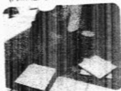
4. Assentar Peças (Auxílio Martelo de Borracha)
